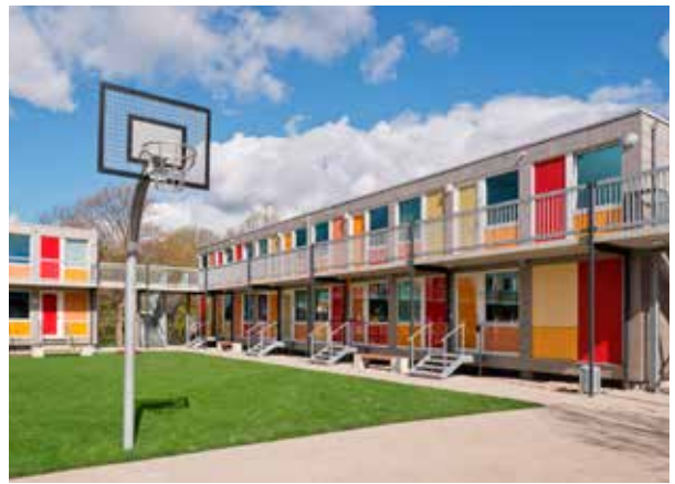
IN HANNOVER STAAN DIVERSE HOUTEN, PREFAB MODULES.
